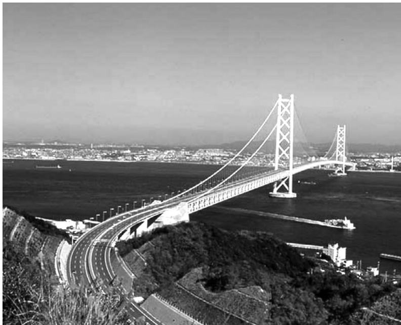
Рис.1.13. Висячий мост Акаси — Кейкио между островами Хонсю и Сикоку (Япония). Главный пролет 1991 м. (1998г.)
