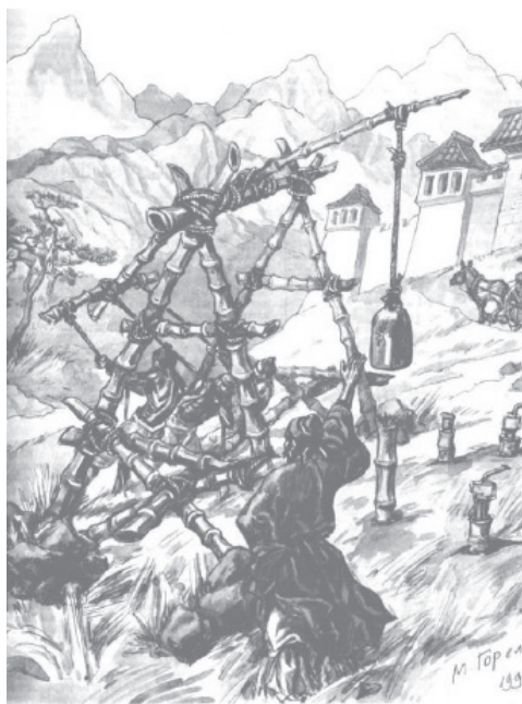
Рис. 1.1. Сооружение скважин в Китае: бронзовой колотушкой в скважину забивалась обсадная труба из бамбука
