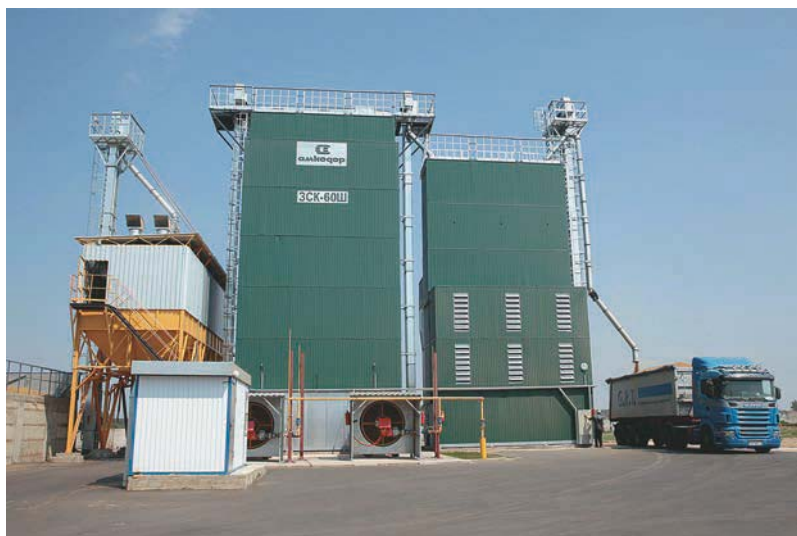
Новый зерносушильный комплекс ЗСК-60Ш «Амкор» работает в ОАО «Агрокомбинат «Юбилейный»» Орианского района
