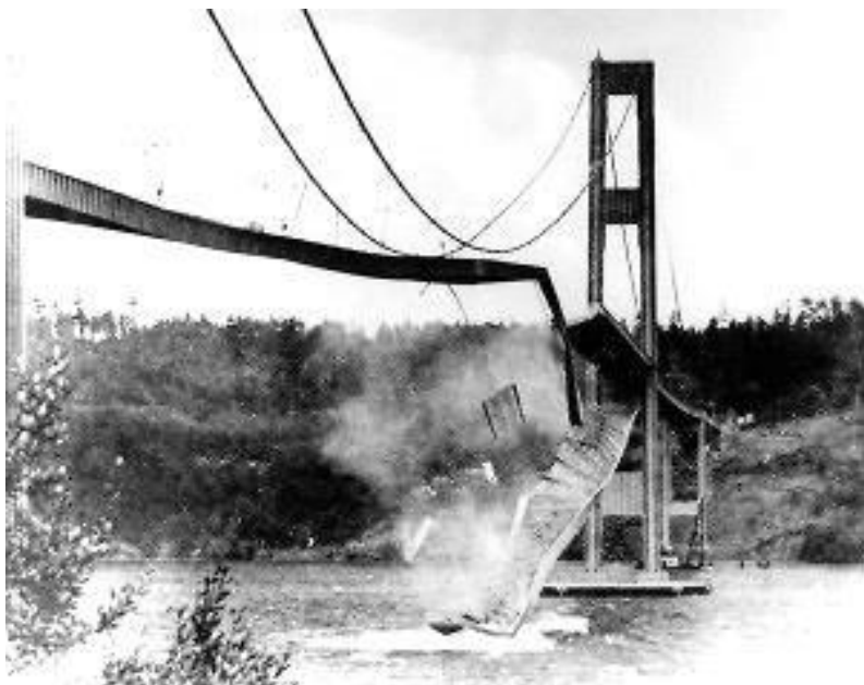
Рис. 1. Разрушение Такомаского моста
