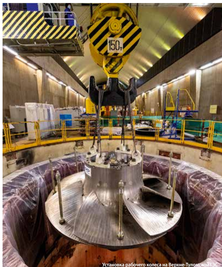
Установка рабочего колеса на Верхне-Тулумской ГЭС
