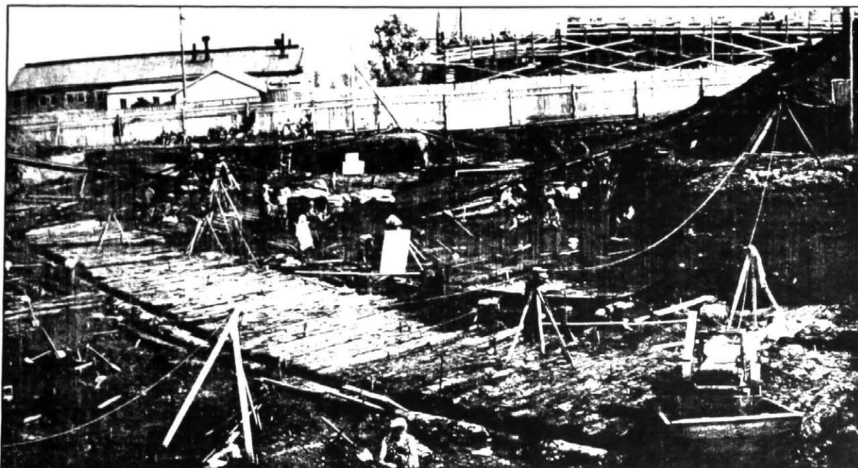
Рис. 7. Вскрытая раскопками мостовая одной из центральных улиц средневекового Новгорода
