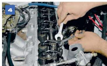
Вместо отвертки регулировочный винт можно удерживать ключом «на 11».
