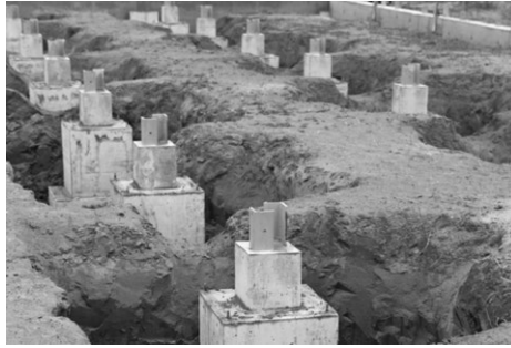
Рис. 1.2. Возведенный столбчатый фундамент
