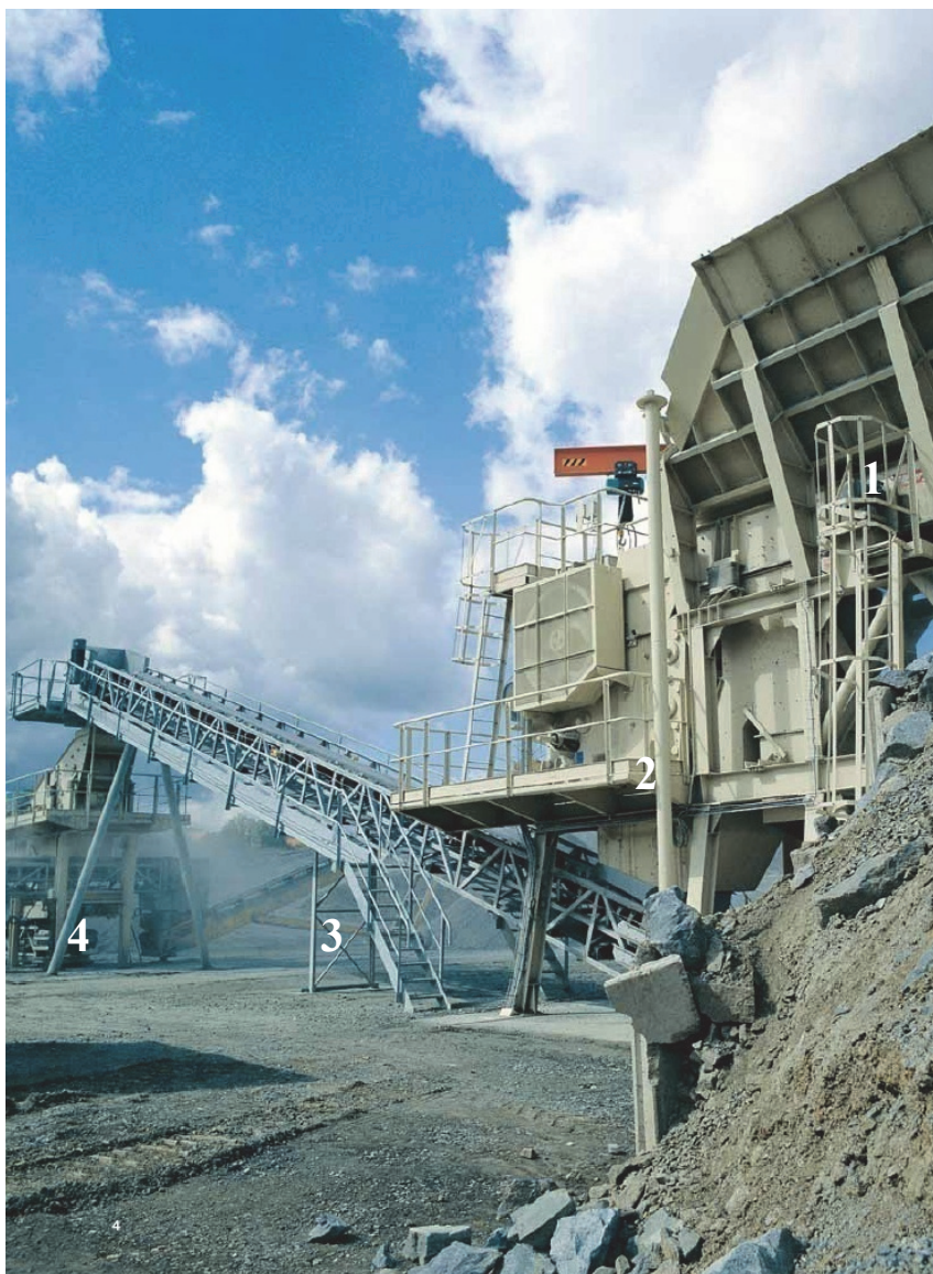
Рис. 1.8. Дробильно-сортировочный комплекс, установленный в карьере: 1 – приемный бункер; 2 – щековая дробилка; 3 – ленточный конвейер; 4 – инерционный грохот
