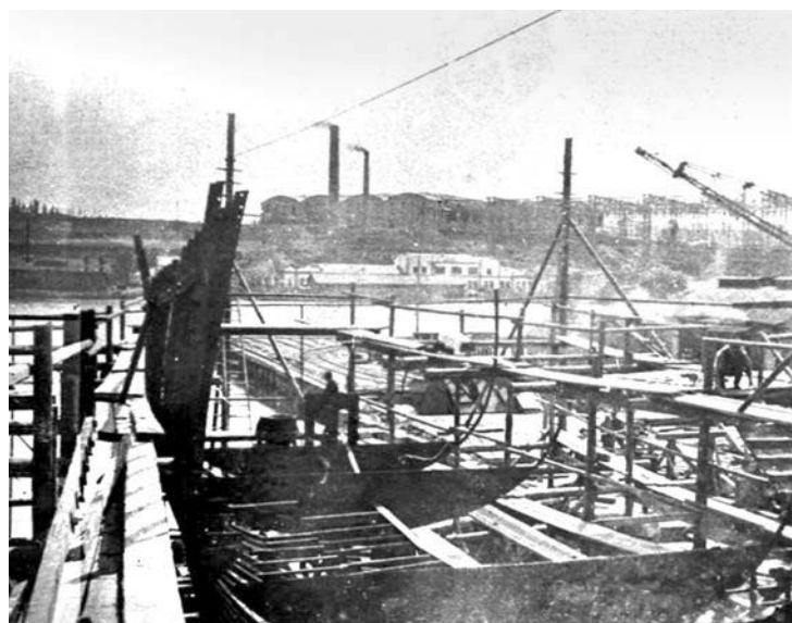
Сборка корпусных конструкций эскадренного миноносца «Громкий» на стапеле Николаевского отделения Невского завода, август 1913 г. Частично установлены днищевой набор и шпангоуты правого борта
