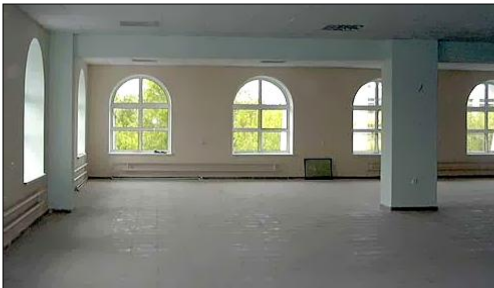
Рис. 1.1. Фото помещения, в котором будет кафе
