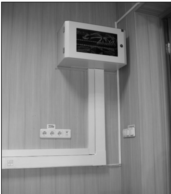
Рис. 1.3. Нормальная коммутация кабелей и размещение оборудования
