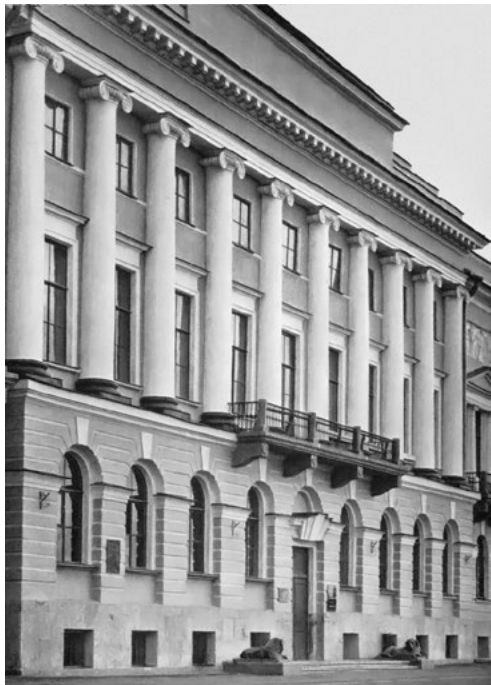
Дом Лаваль: над полуциркульными окнами 1-го этажа колоннада из 10 ионических колонн , увенчанная аттиком
