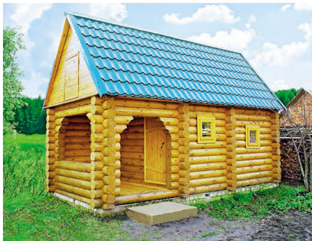
Срубы из оцилиндрованного бревна готовятся заводским способом
