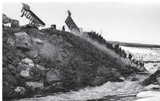
Возведение будущей Вилуйской ГЭС началось с перекрытия реки Вилуй. Мирный, ЯАССР, 1964 г.
