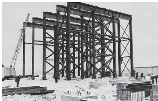
Строительство фабрики № 12. Поселок Удачный, ЯАССР, 1974 г.
