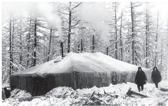
Палатка, в которой размещалось управление треста «Якуталмаз». Поселок Мирный, ЯАССР, 1958 г.
