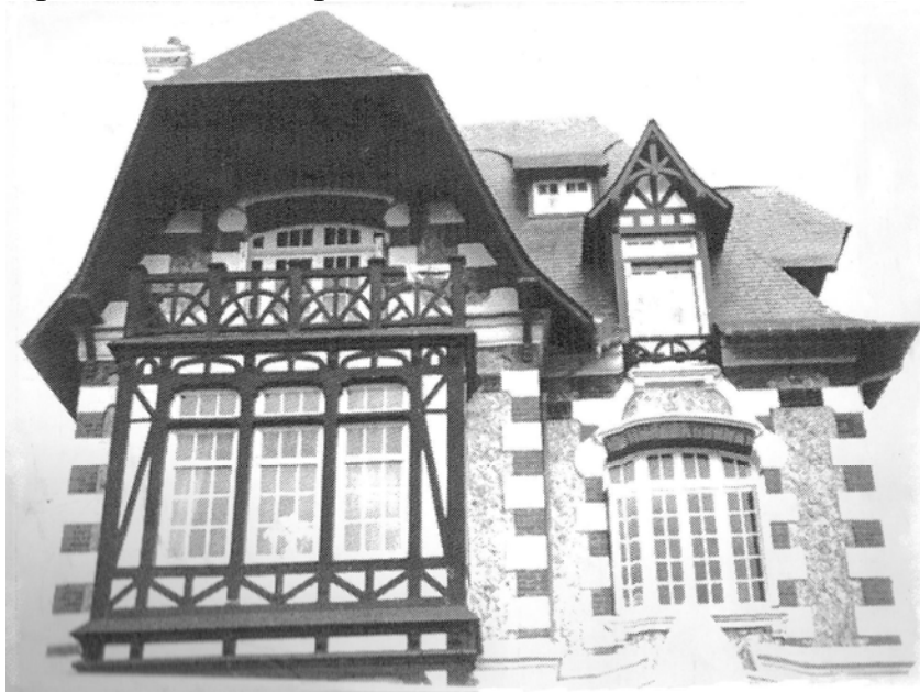
Рис. 5. Образец фахверкового решения деталей современного здания (выносной эркер)
