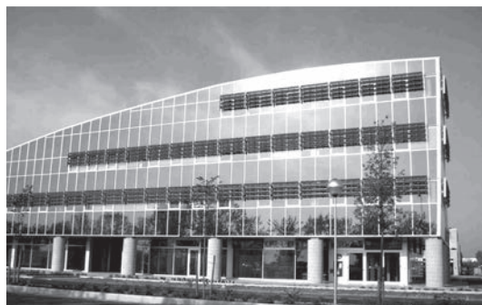
Рис. 4. Дополнительная наружная солнцезащита в комбинации с открывающимися окнами [14]
