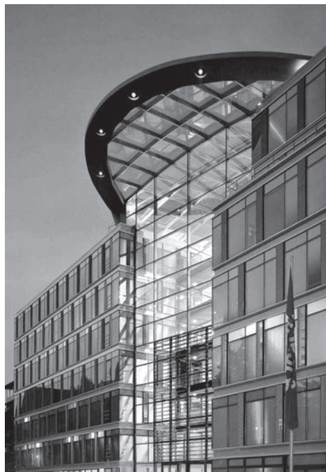
Рис. 5. Административное здание с вентиляционными клапанами и фотогальваническими модулями. Открывающиеся окна, расположенные за экраном наружной солнцезащиты
