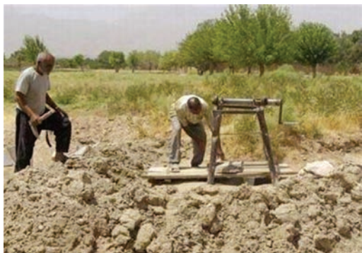
Рис. 7. Моханди во время сооружения кяриза: при проходке шахты грунт удаляется с применением кожаных мешков [11]
