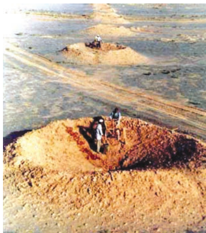
Рис. 2. Вид протяженного кяриза Мохандими во время дноуглубительных и восстановительных работ [2]
