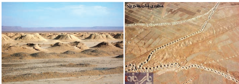
Рис. 1. Система кяризов в пригороде г. Йазд: а — вид с поверхности земли; б — вид сверху [2]
