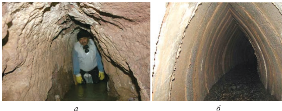
Рис. 8. Формы поперечного сечения горизонтального канала: а — канат г. Гонабад (изначальная форма подземного тоннеля в скальном грунте); б — канат Кавал (завершенная форма тоннеля в ограждающих конструкциях стрельчатой формы)
