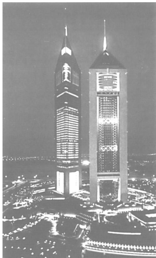
Рис. 1.1.7. Здания с монолитным железобетонным каркасом
