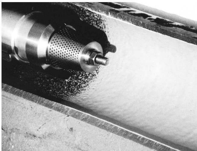
Рис. 1.1. Иллюстрация нанесения защитного покрытия набрызговым методом
