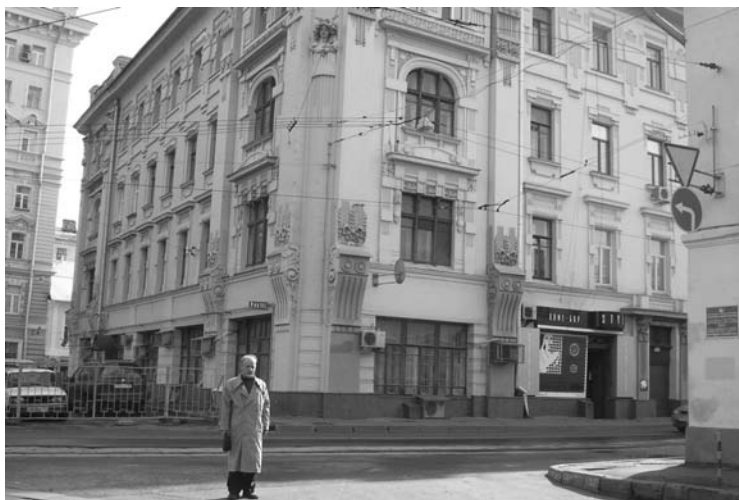
Рис. 1. Общий вид здания старой постройки
