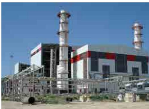
В составе энергоблока две промышленные газотурбинные установки Trent-60 производства Rolls-Royce мощностью по 60 МВт, два котла-утилизатора ПК-93 (ОАО «ЗИО-Подольск»), паровая турбина Siemens SST-400 мощностью 15 МВт.
