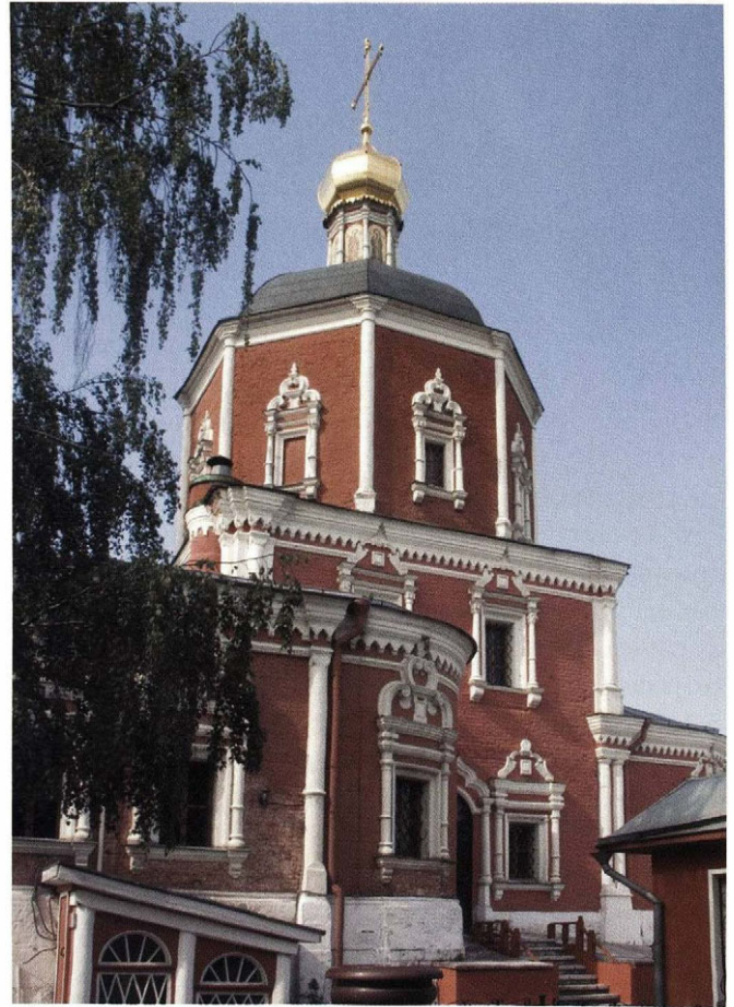
Москва. Церковь Святых Петра и Павла «что над Яузой». Начало строительства 1700–1702
